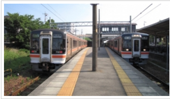
▲半田駅での列車交換。架線が張り終わっているのがわかる。
