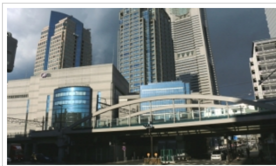
▲東急の高架を結ぶ橋。もう歩いて渡れそうだ。
